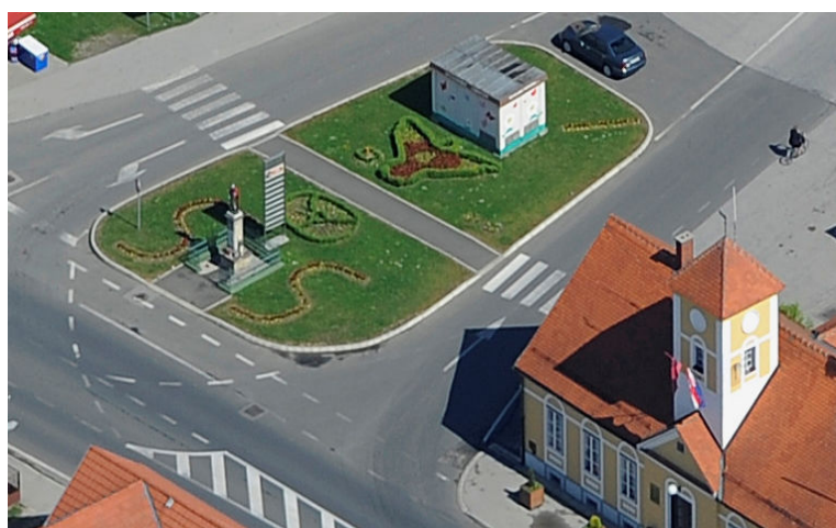
Slika 12: Trafostanica na Trgu Sv. Mihaela
