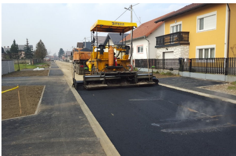
Slika 8: Gradnja ceste u Općini Sračinec
