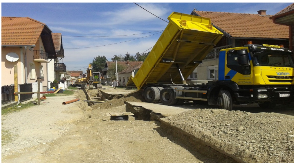
Slika 13: Izgradnja kanalizacije u Općini
