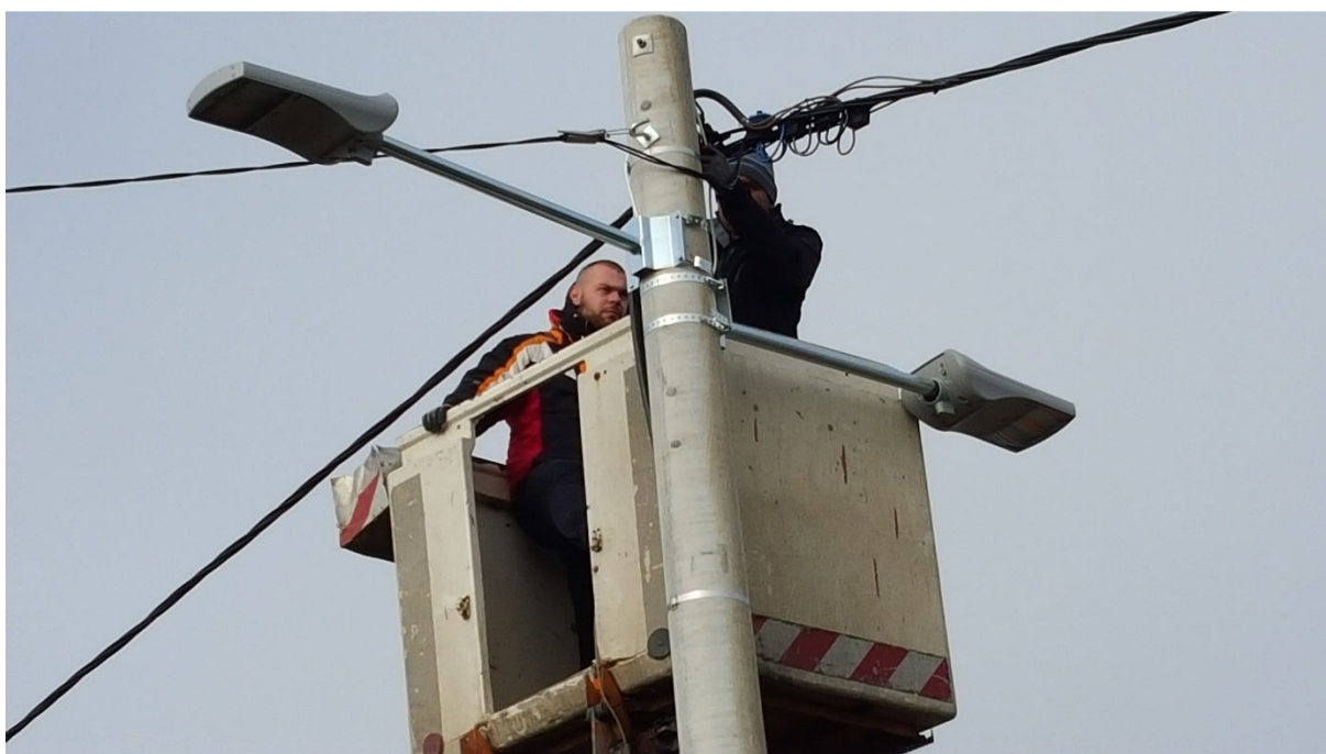
Slika 31: Postavljanje LED rasvjete
